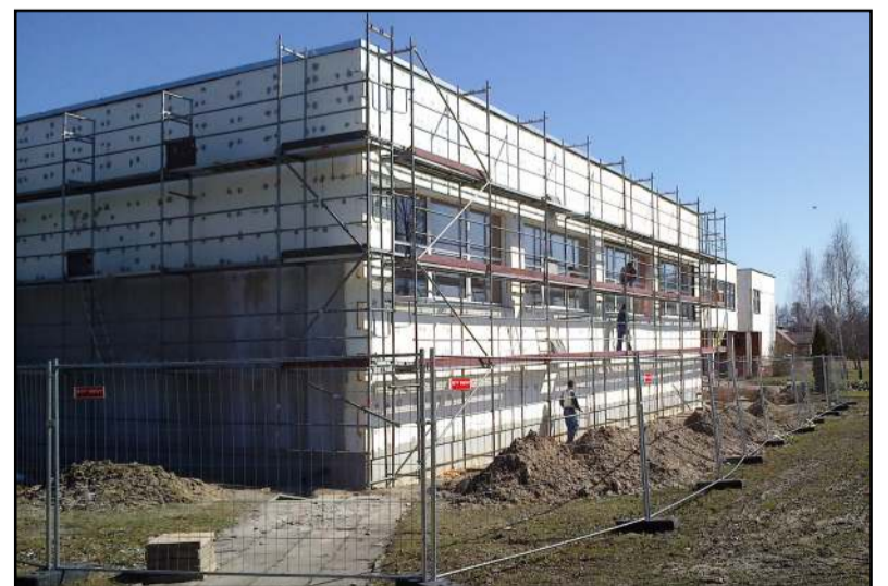
Statybininkai jau pasirengę pradėti dažyti būsimą universalaus daugiavilniame centro fasadą
